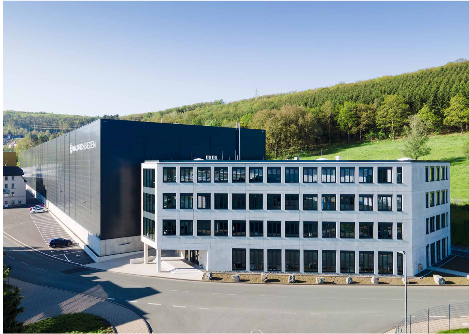
Das neue Verwaltungsgebäude bietet 3.500 m 2 modernste Fläche für neue Bürokapazitäten
